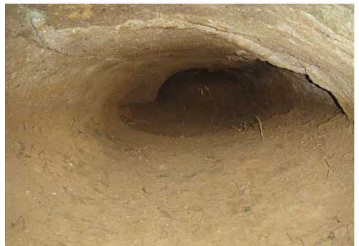
La conduite forcée progresse sous voute au milieu des racines
